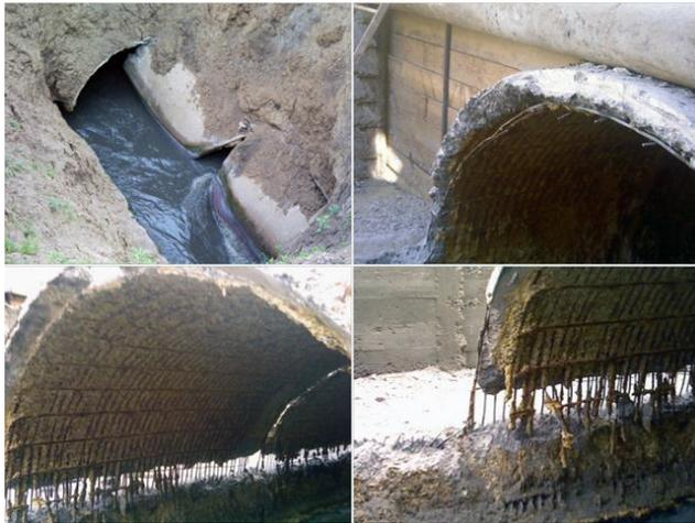
*Рисунок 1 – Состояние участков канализационного железобетонного коллектора*
