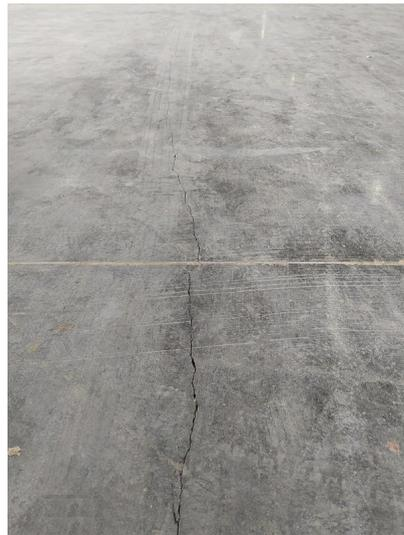
*Рисунок 2 – Трещины от колесного транспорта*
