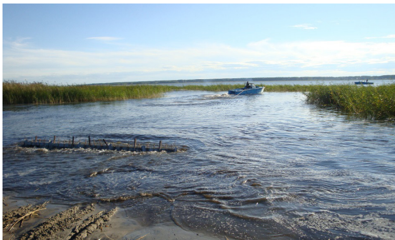
Рисунок 2. Начало процесса рыхления донных отложений озера заморного типа
