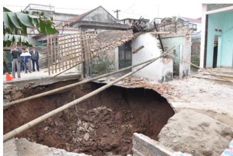
Рисунок 9. Обвал земной поверхности в районе Мидык в декабре 2010 г.
